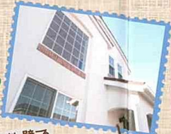
塗り壁の外壁でナチュラルハウスの実現
